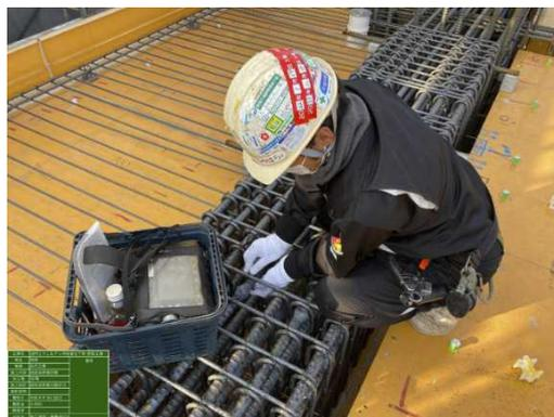
写真4 梁筋超音波探傷試験状況
