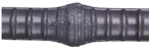
写真7.2 ふくらみの直径不足
